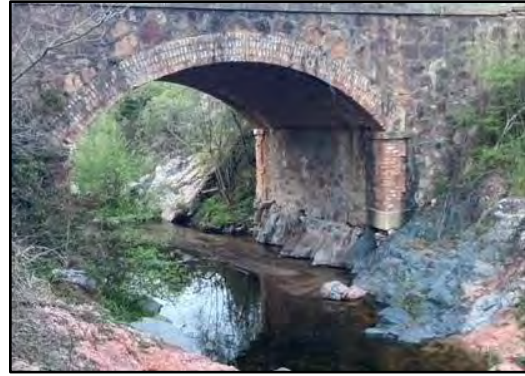
Figura A.4.14. Pont de Fàbregues (Font: pròpia).
