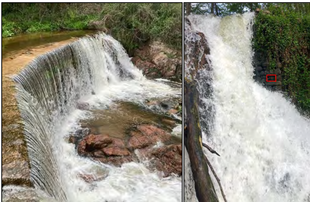
Figura 37. Resclosa abans de la Cantina (esquerra) i la resclosa d'en Cosme després de dies intensos de pluja i tempesta, la riera Major està desbordada esdevenint un problema per a les merles d'aigua i els seus nius (Font: pròpia).
