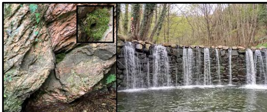
Figura A.4.13. Resclosa de la Casa de Colònies (Font: pròpia).
