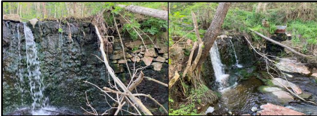
Figura A.4.11. Resclosa de la gasolinera (Font: pròpia).
