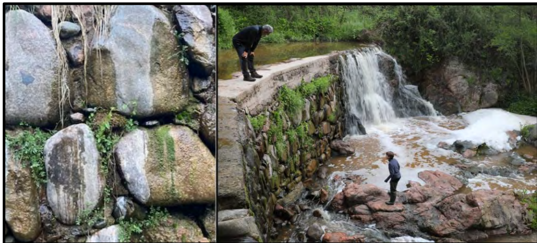
Figura A.4.16. Resclosa d'abans de la Cantina. (Font: pròpia).
